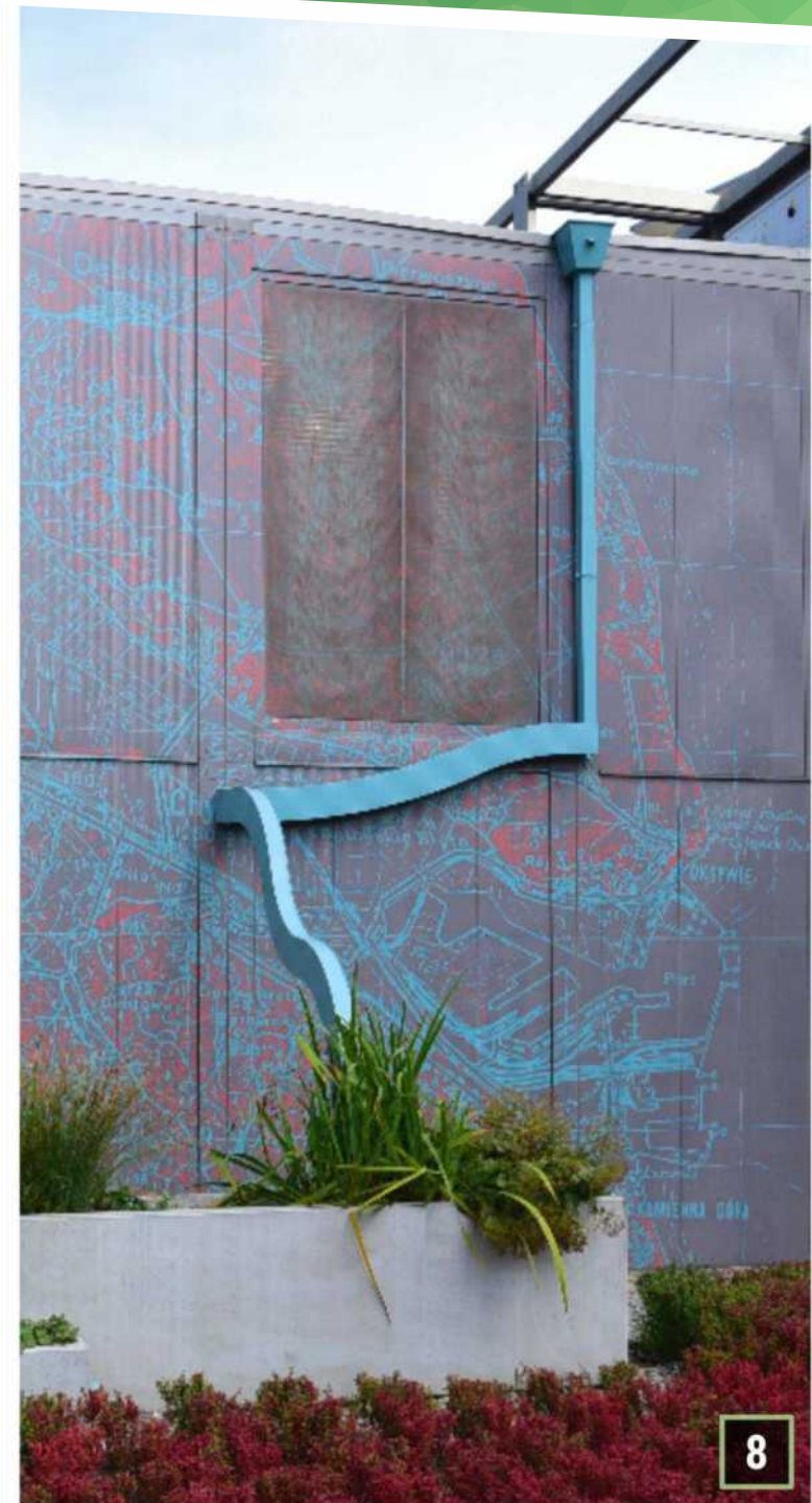
Fot. 8–10. Ogród deszczowy w pojemniku, budynek InfoBoxu w Gdyni (Gdynia, M. Śpitalniak)
